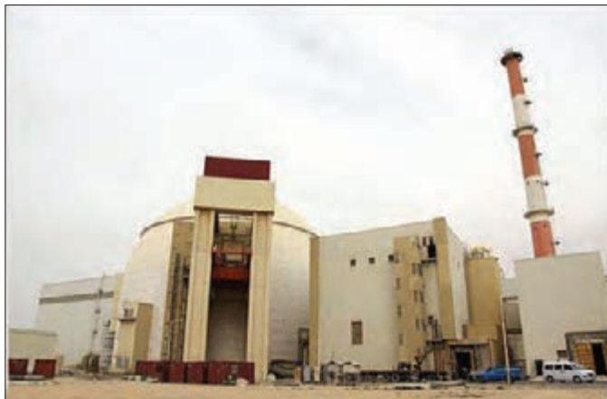
نیروگاه اتمی بوشهر
