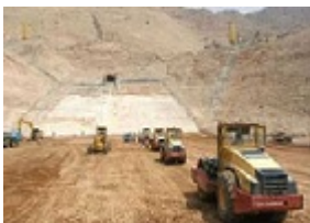
مراحل ساخت سد خاکی
